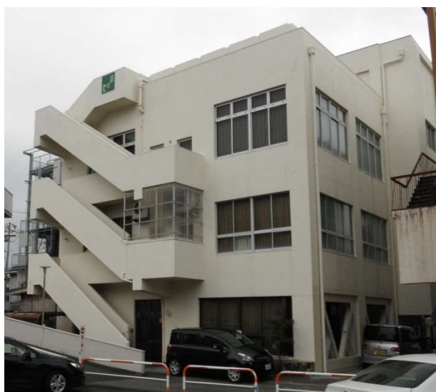
図 4-17 避難誘導標識（田辺市医師会館）
