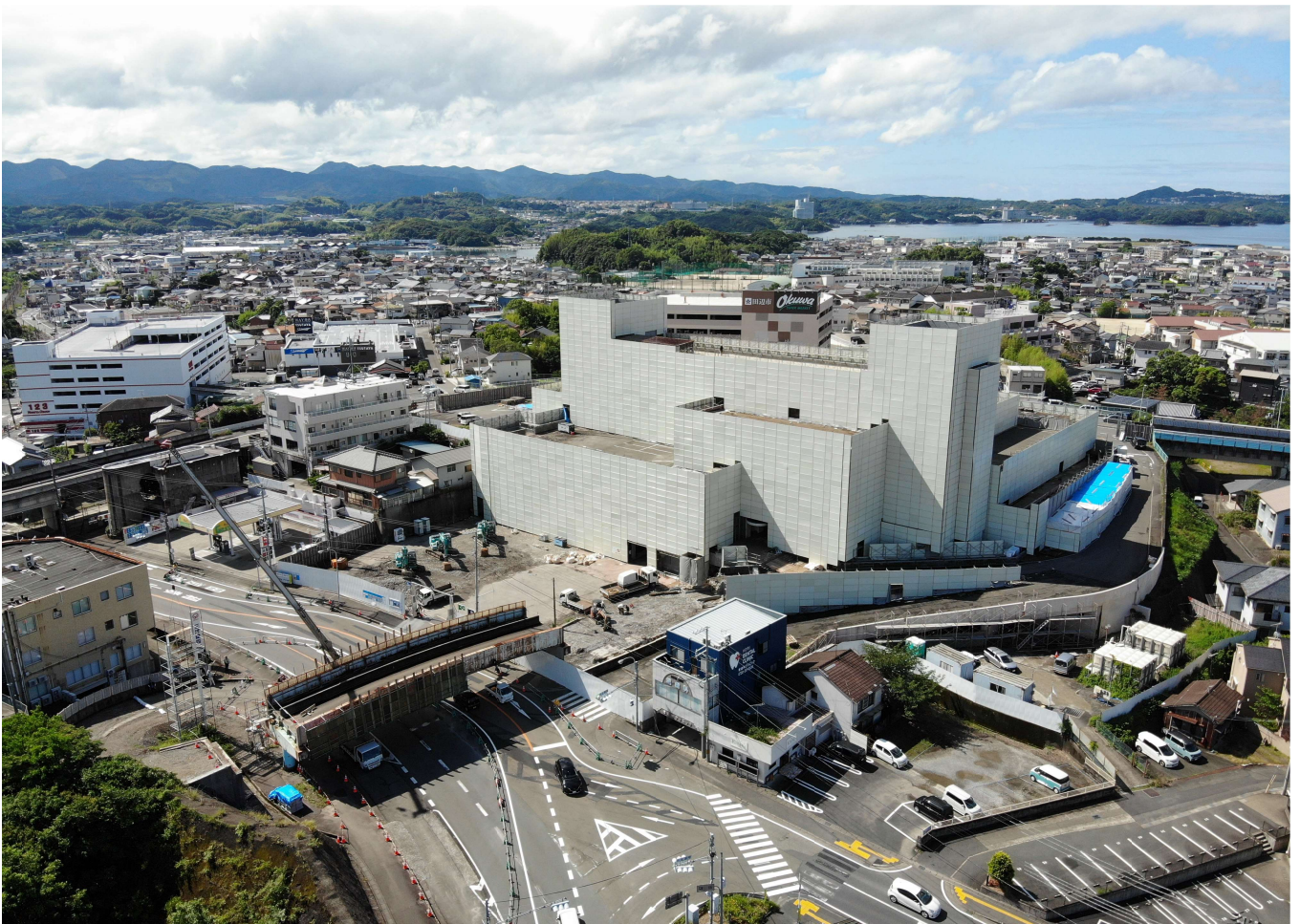
令和3年6月17日（木）撮影 田辺市新庁舎工事状況写真
