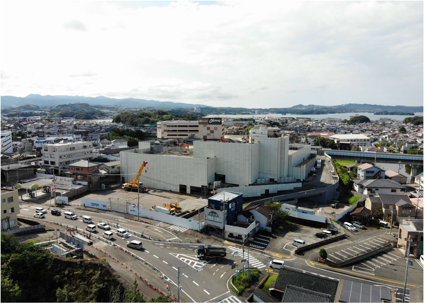
令和3年9月9日（木）撮影 田辺市新庁舎工事状況写真
