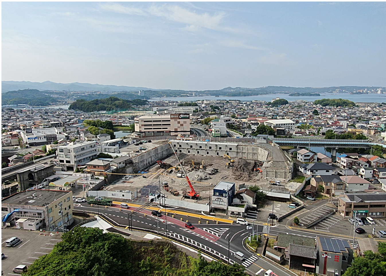
令和4年 5月25日（水）撮影 田辺市新庁舎工事状況写真
