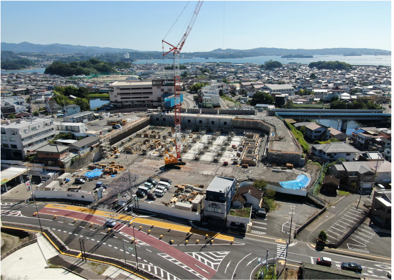
令和4年 9月24日 (土) 撮影 田辺市新庁舎工事状況写真
