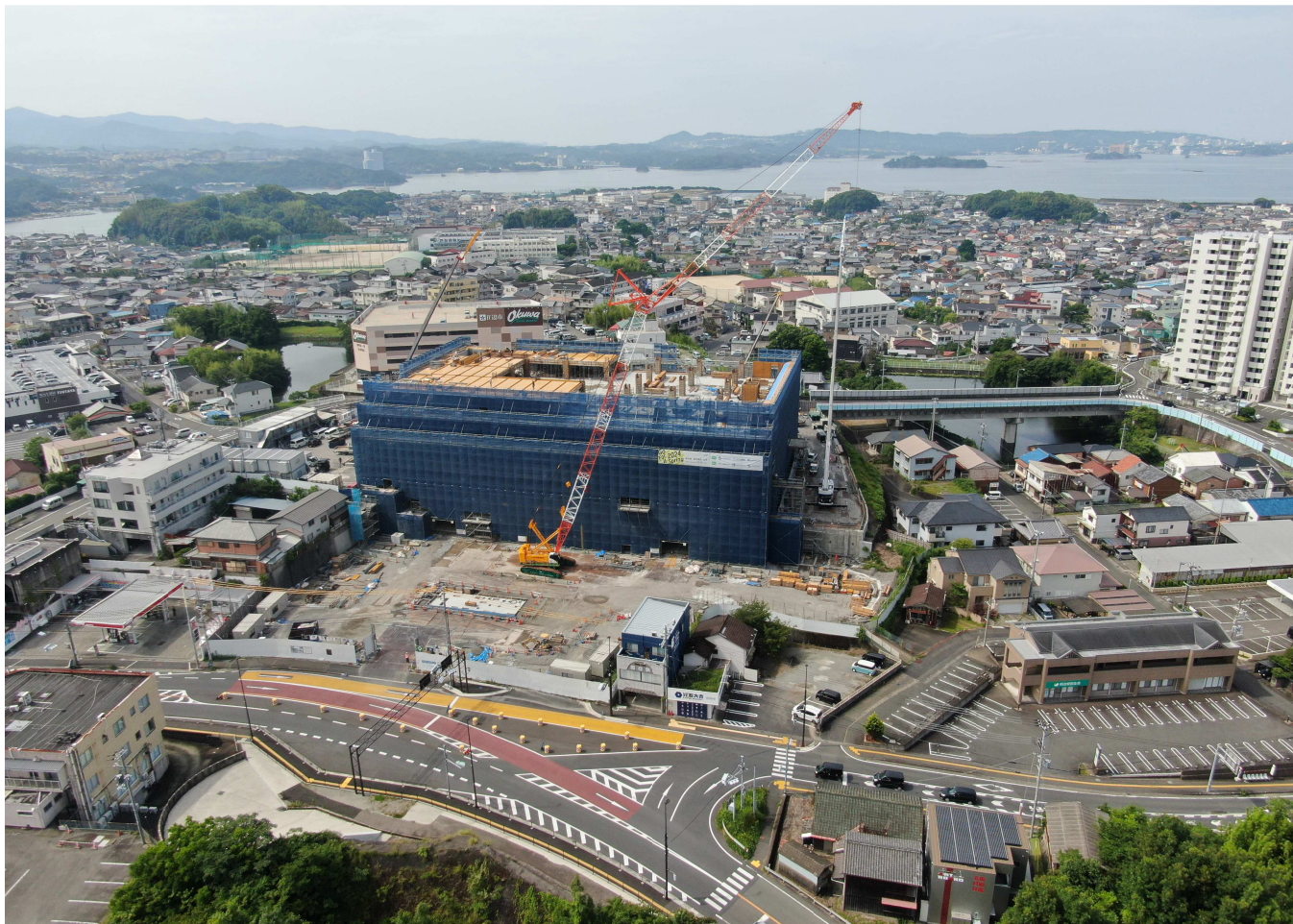
令和5年 6月24日（土）撮影 田辺市新庁舎工事状況写真
