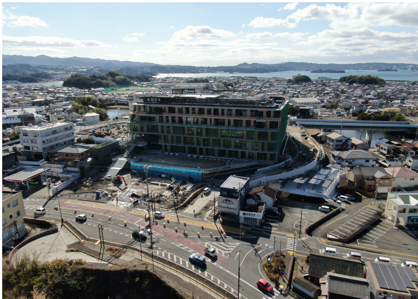
令和6年 1月26日（金）撮影 田辺市新庁舎工事状況写真
