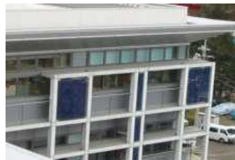
建材一体型合わせガラス 太陽電池モジュール
