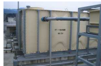
屋上雨水貯留槽
