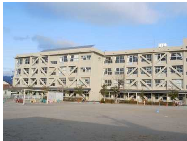
K 型鉄骨ブレース工法による建物イメージ
