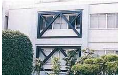
K 型外部鉄骨ブレース工法
