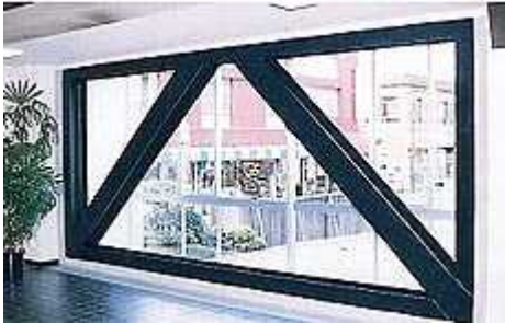
K 型内部鉄骨ブレース工法
