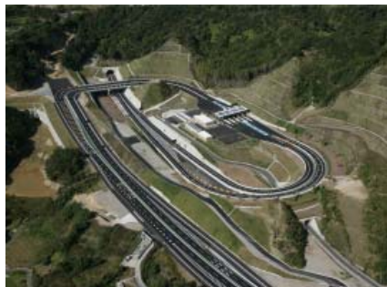
南紀田辺インターチェンジ
