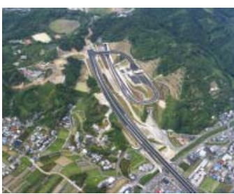
南紀田辺インターチェンジ
