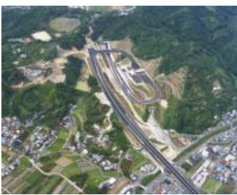
南紀田辺インターチェンジ
