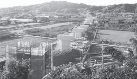
南伸工事が進む近畿自動車道紀勢線
