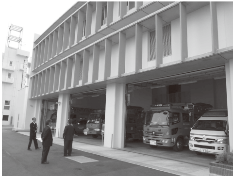
免震化された消防庁舎
