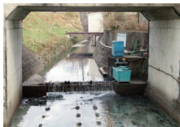
浄化方法は、切戸橋の下流の背戸川排水路に堰を設け、汚水中に酸素を送り込み、好気性微生物（バクテリア）が息できる環境を整え、汚水を浄化する能力を持つ「バクテリア」と「酵素」を定量供給することにより、バクテリアを増殖させ、水質の浄化を図るというものです。
