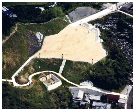
橋谷避難広場 昭和21年12月21日に発生した昭和南海地震で被害の大きかった新庄町橋谷地区に、津波災害時に緊急的に一時避難する場所として平成20年3月に約2,500㎡の広場を整備しました。
