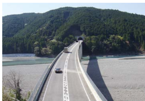
一般国道168号 本宮道路 本宮町大居～土河屋間を結ぶバイパスです。大型車両の対向ができない場所もありましたが解消され、観光客の利便性も向上しました。
