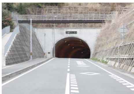
一般国道425号 福井バイパス 龍神村柳瀬～福井間を結ぶバイパスの完成により、龍神地域の観光振興や災害時の緊急輸送の強化につながりました。
