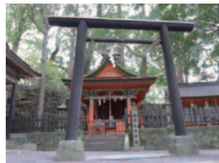
たかはらくまのじんじやほんでん 高原熊野神社本殿 県指定有形文化財
