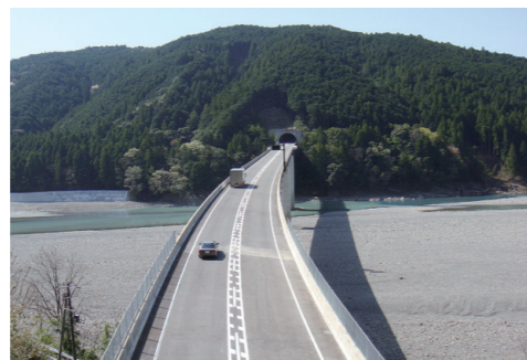
一般国道168号 本宮道路 本宮町大居～土河屋間を結ぶバイパスです。大型車両の対向ができない場所もありましたが解消され、観光客の利便性も向上しました。
