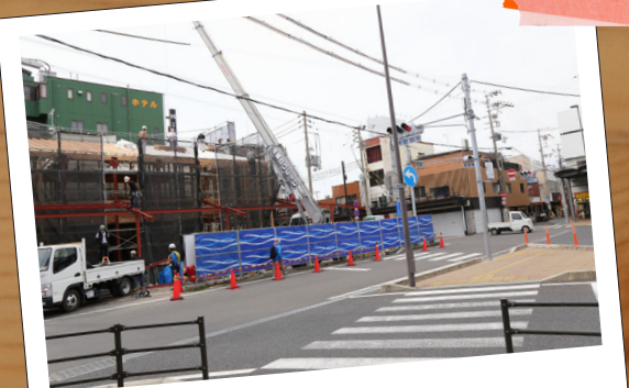
建設中の市街地活性化施設
