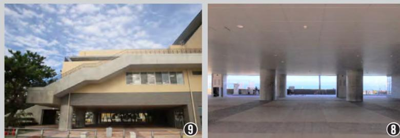
1階は巨大地震等に伴う津波が発生した際、波が抜けていくような構造としています。
