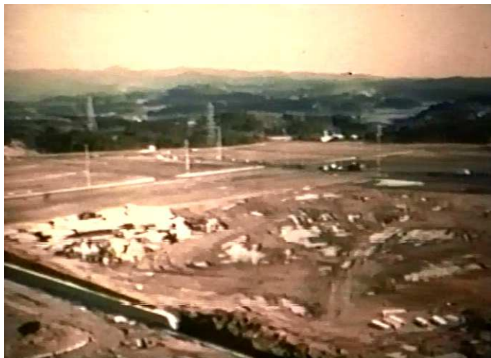
【造成時の写真：朝日ヶ丘と新万の境界付近】
