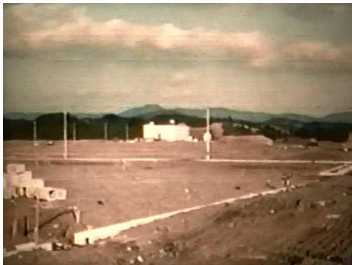
【造成時の写真：中央は新万団地1号棟】
