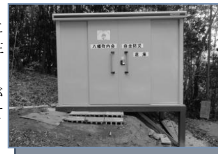
新設された防災倉庫
