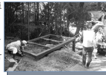
基礎工事の様子
