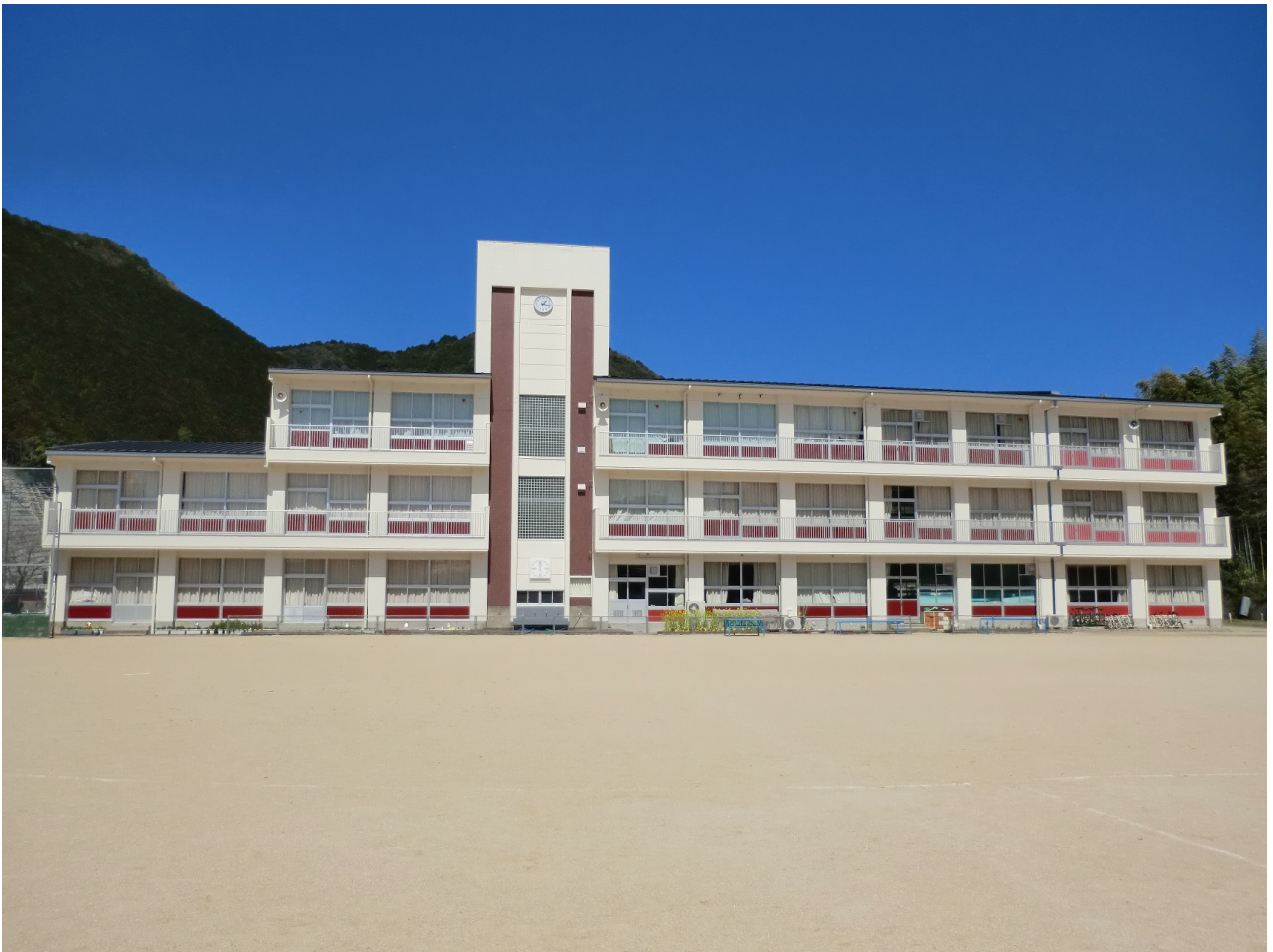
田辺市立鮎川小学校（外壁改修事業）
