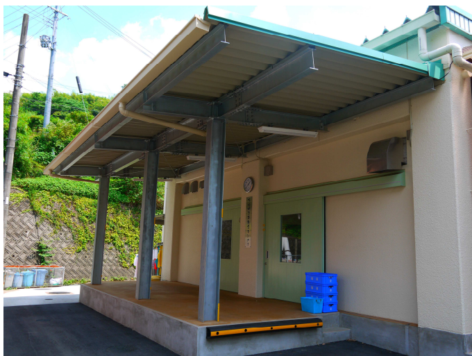
大塔中辺路給食センター外観
