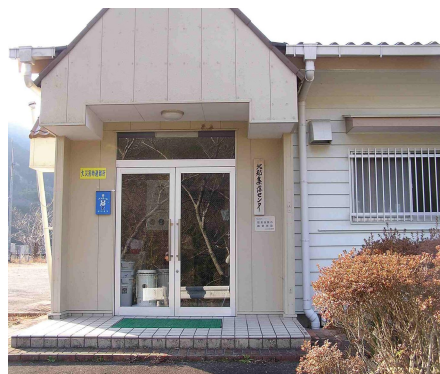
【栗栖川下分館(北郡集落センター)】
