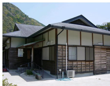
【甲斐ノ川分館（甲斐ノ川地域防災センター）】
