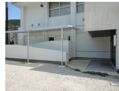
グラウンド方面出入口
