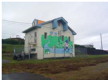
河川取水ポンプ室
