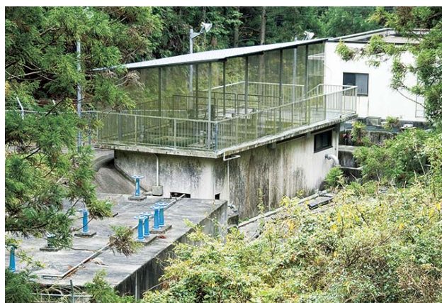
鮎川簡易水道（下附水系）浄水場
