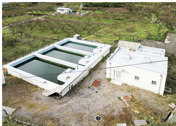
長野簡易水道浄水場
