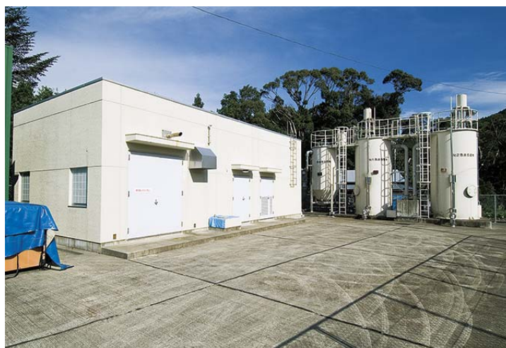
栗栖川簡易水道浄水場
