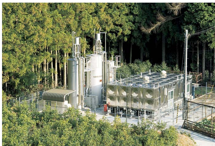
湯ノ又・上広井原簡易水道浄水場
