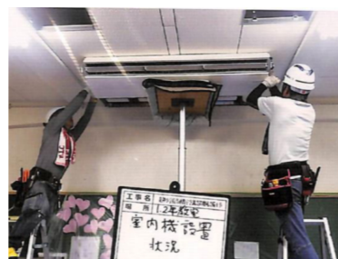
小学校空調設備整備
