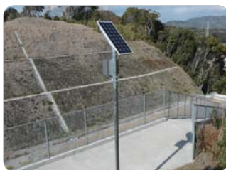
①避難誘導灯
