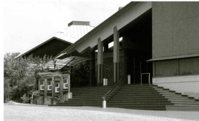
改修工事の完了した入り口付近
