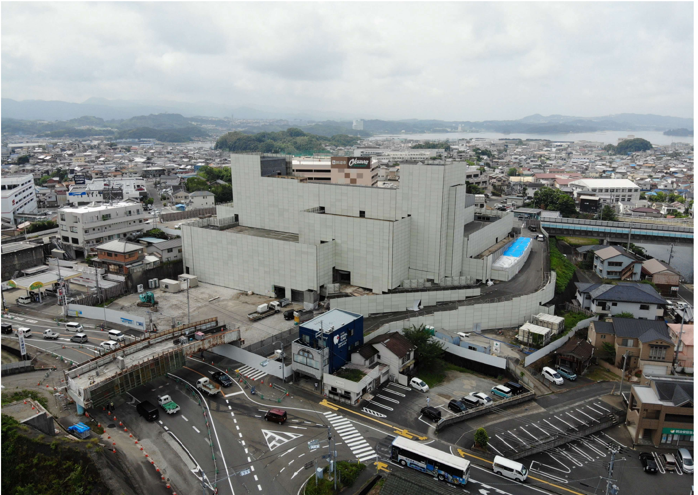
令和3年7月6日（火）撮影 田辺市新庁舎工事状況写真
