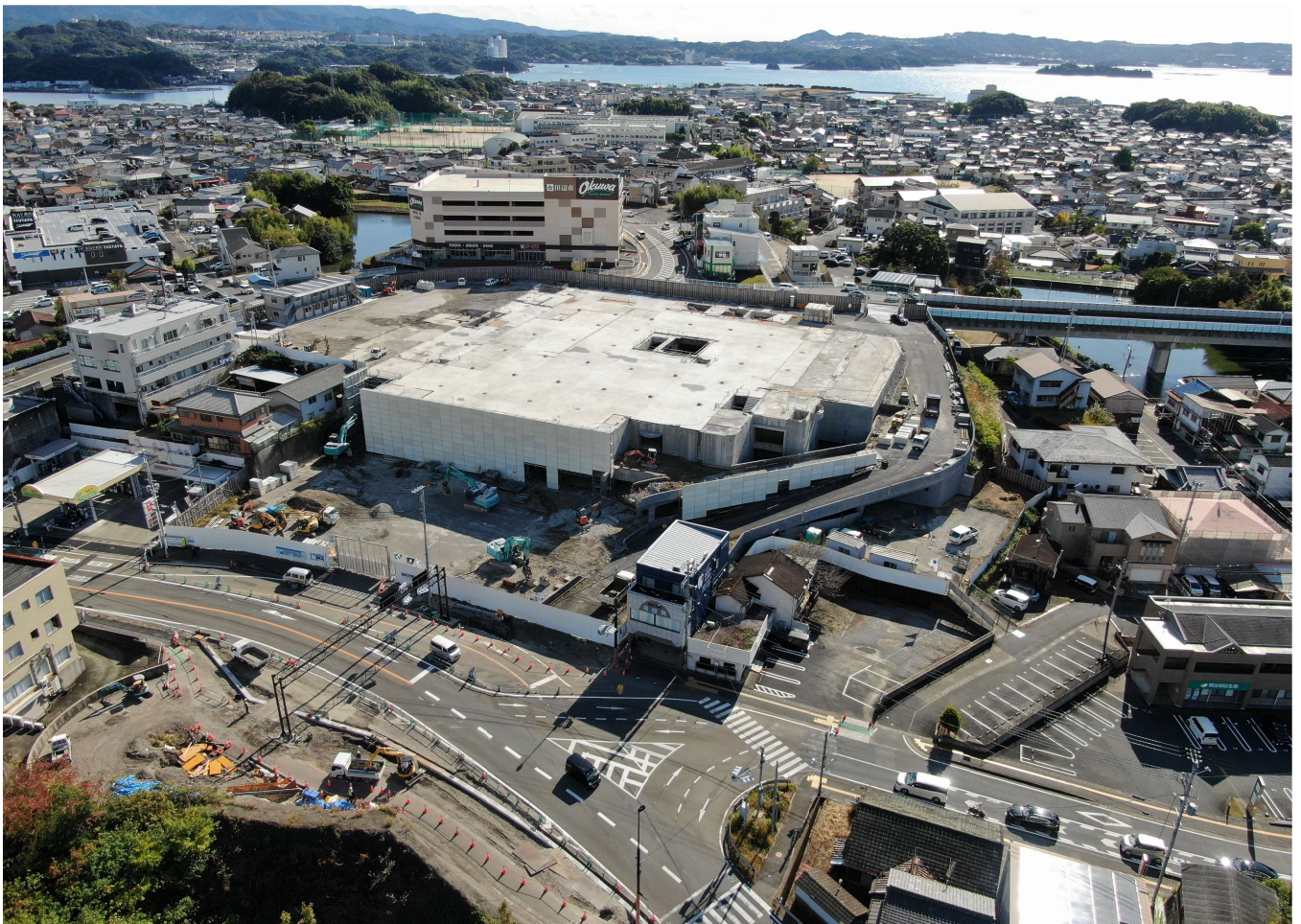
令和3年11月10日（水）撮影 田辺市新庁舎工事状況写真
