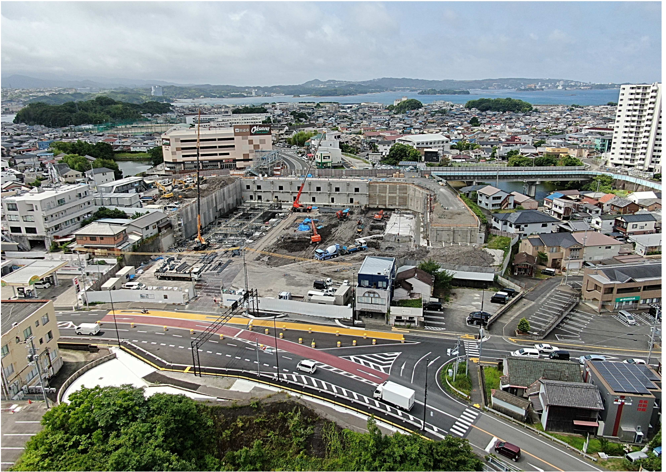
令和4年 6月24日（金）撮影 田辺市新庁舎工事状況写真
