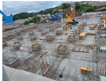
庁舎棟中央付近
