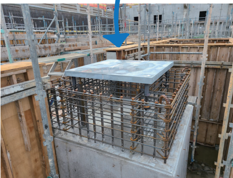
ベースプレート設置状況
