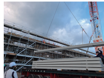
寸法確認後 吊り上げ。
