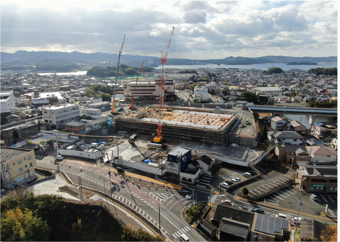
令和4年 12月24日（土）撮影 田辺市新庁舎工事状況写真
