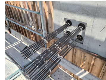
コンクリート打設後のPC鋼線です。
