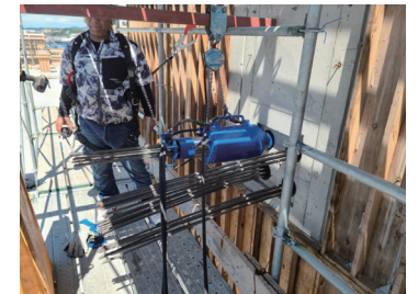
この機械により、PC鋼線を引張り、固定すると、圧縮力が加わります。
