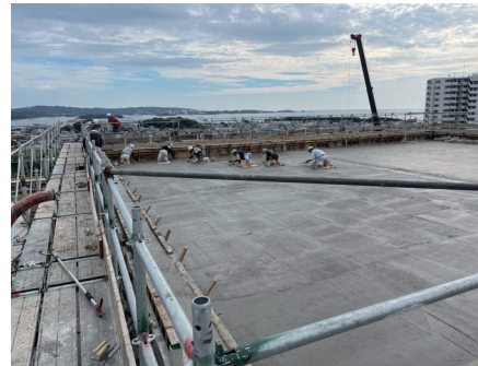
8/18 屋上コンクリート打設状況 ←左図の議場部分の屋根です。上棟完了
