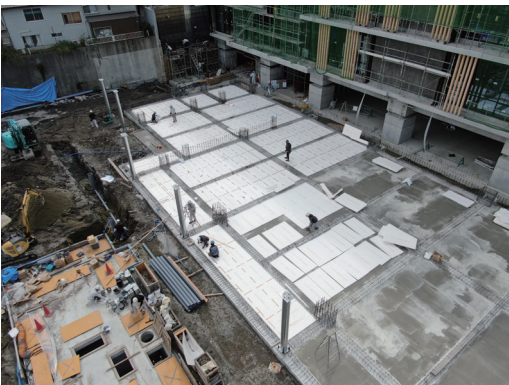
※床下断熱材の設置作業中です。※
