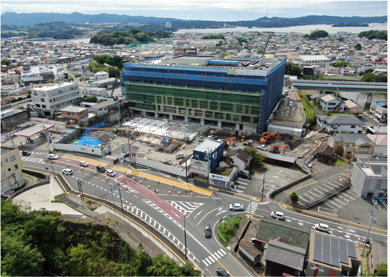
令和5年 9月23日（土）撮影 田辺市新庁舎工事状況写真
