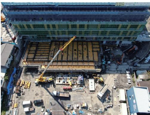
型枠が完了し、鉄筋工事中です。
