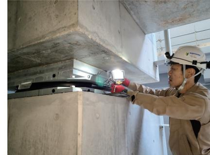
装置の内部のコア部分もスコープで点検しています。
