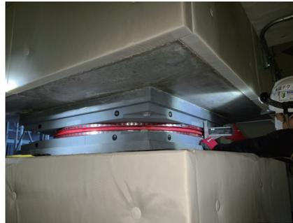
免震装置が上下でずれていないか計測中
