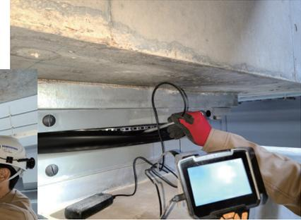
免震建物側と地球側で、地震動が異なる部分の壁や床はエキスパンションジョイント（伸縮継手）により繋がります。
