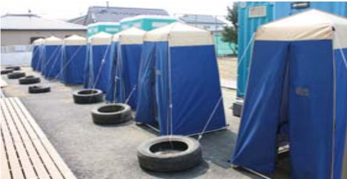
【マンホールトイレ】
