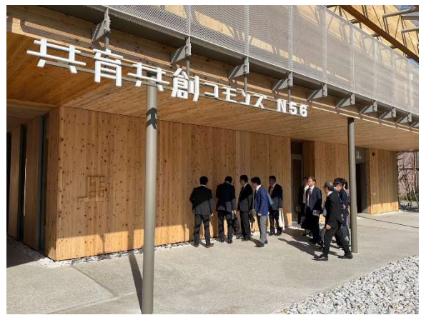
「外壁部材の杉板にある抜け節(死節)の補修技術に注目」
