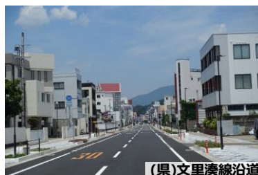
(県)文里湊線沿道
