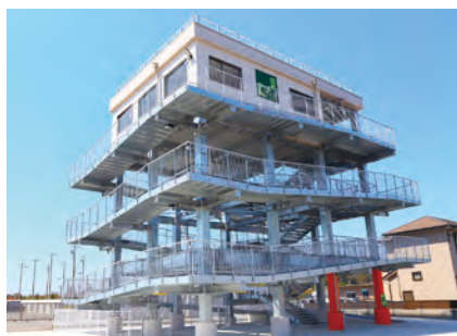
津波避難タワーの整備
