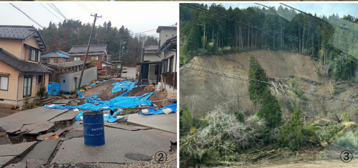
▲①住宅が大きく倒壊②地面の隆起による地割れした道路③山腹から崩壊した斜面
