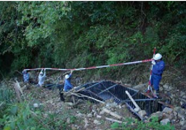
▼農業用施設現地調査（測量等）
