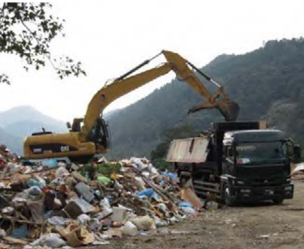
▼仮置場からの搬出状況
