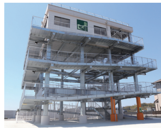
芳養地区津波避難タワー 南海トラフ巨大地震の津波浸水想定に基づく津波避難困難地域を解消するため、津波避難施設の整備などに取り組んでいます。
