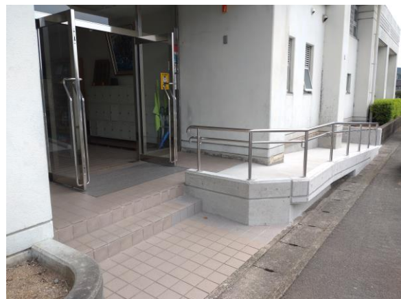
衣笠中学校バリアフリー化工事
