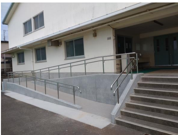
明洋中学校バリアフリー化工事
