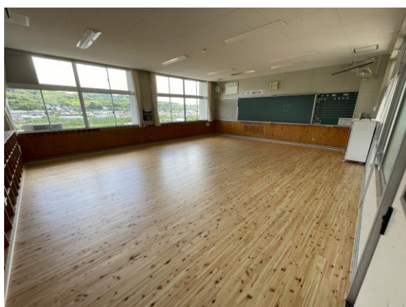
新庄第二小学校床改修工事
