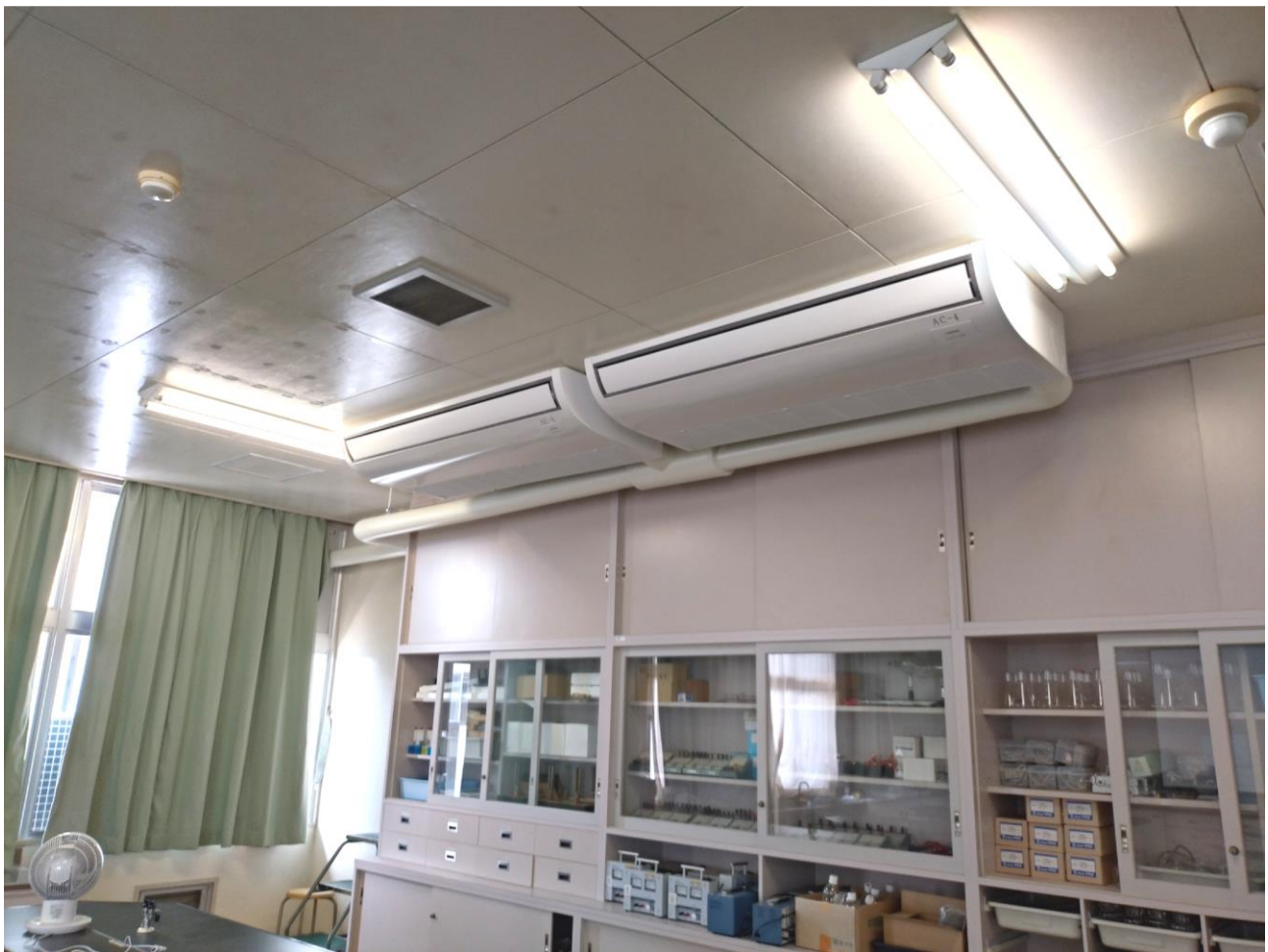
明洋中学校特別教室空調設置工事
