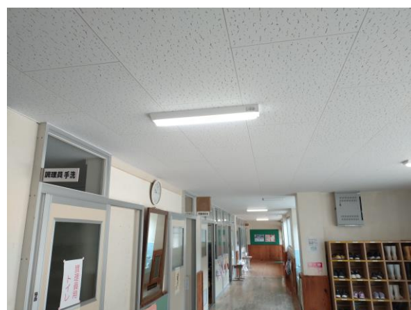
龍神小学校廊下天井改修工事
