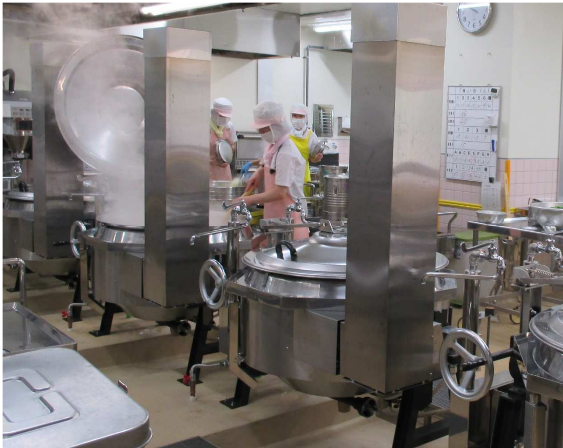
大塔中辺路給食センターより（調理中）
